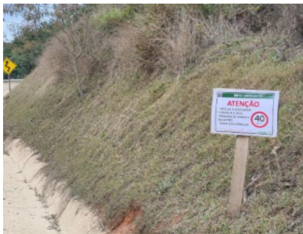
Foto 44 – manutenção em placas de sinalização (Data: 20/08/2022).
