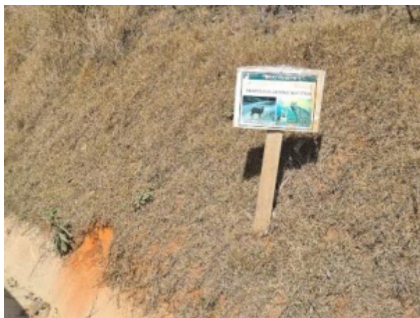
Foto 40 – manutenção em placas de sinalização (Data: 28/07/2022).
