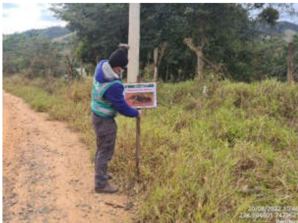
Foto 42 – Instalação placas de sinalização (Data: 20/08/2022).
