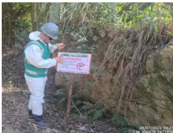
Foto 38 – Instalação placas de sinalização (Data: 28/07/2022).
