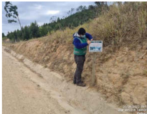
Foto 43 – Instalação placas de sinalização 2 (Data: 20/08/2022).
